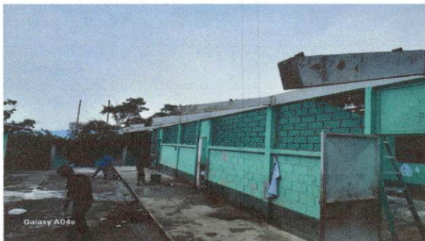
Foto 3: sustitución de techo modulo 2, que incluye 2 aulas y 1 cocina
