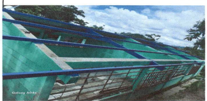
Foto 4: sustitucion de techo modulo 2, que incluye 2 aulas y 1 cocina
