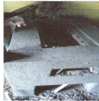
Foto 6: sustitucion completa de estufa rural
