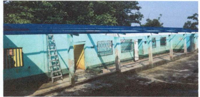
Foto 2: sustitucion de techo de modulo 1 que incluye 3 aulas y 1 direccion
