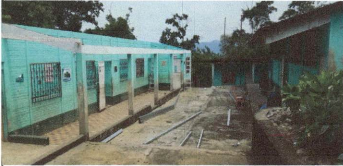
Foto1: sustitución de techo modulo 1 que incluye 3 aulas y 1 direccion
